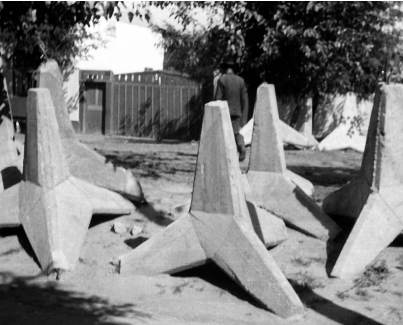
Akadály II. – Betonból öntött harckocsiakadályok 1944-ben (Fortepan)
