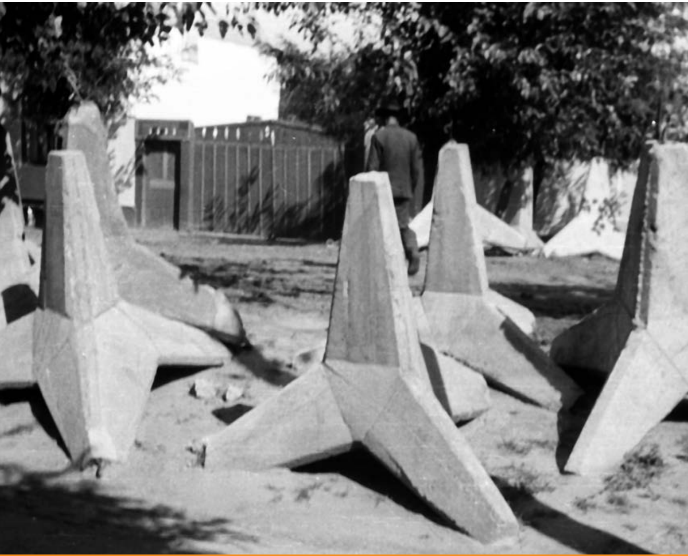
Akadály II. – Betonból öntött harckocsiakadályok 1944-ben (Fortepan)
